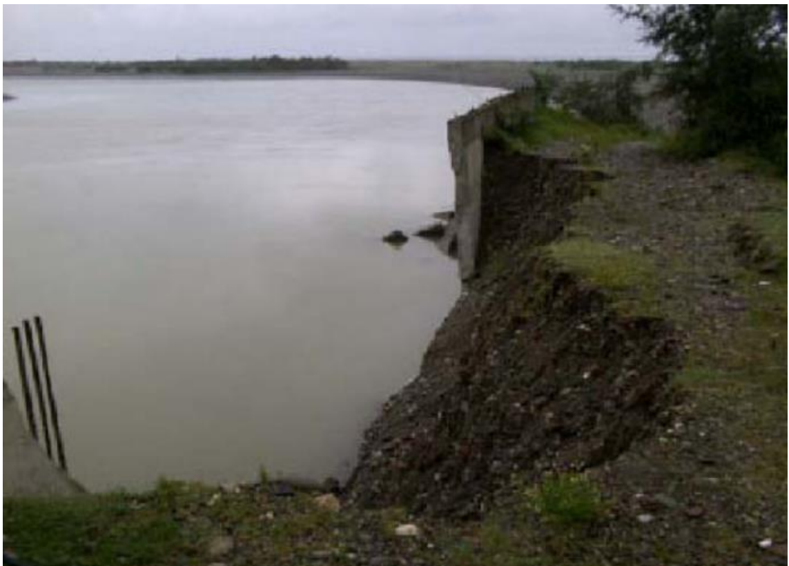
გამოსახულება 3.16 დაზიანებული დამცავი კედელი ბათუმის კონტროლირებულ ნაგავსაყრელზე
